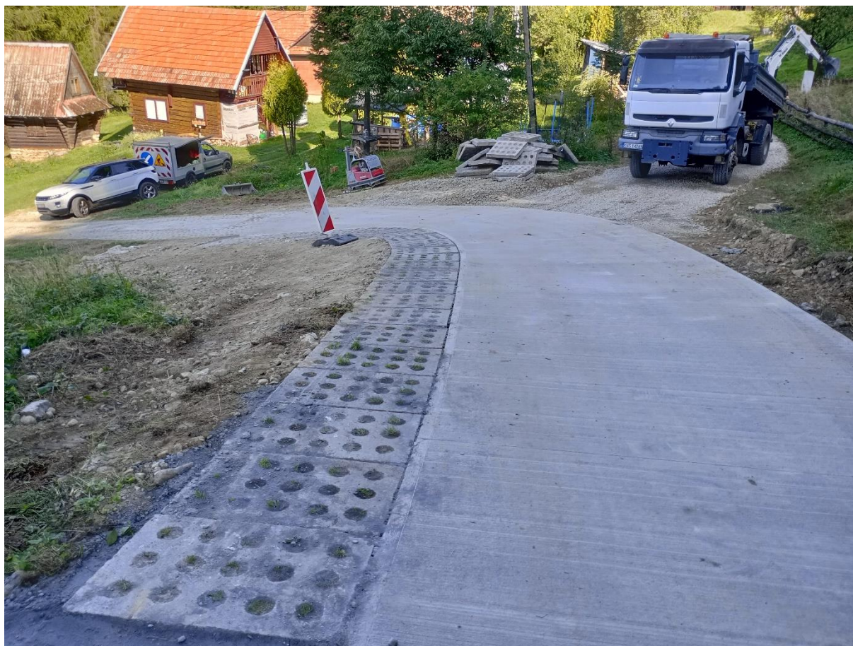
Remont drogi gminnej na osiedlu Makowica.
