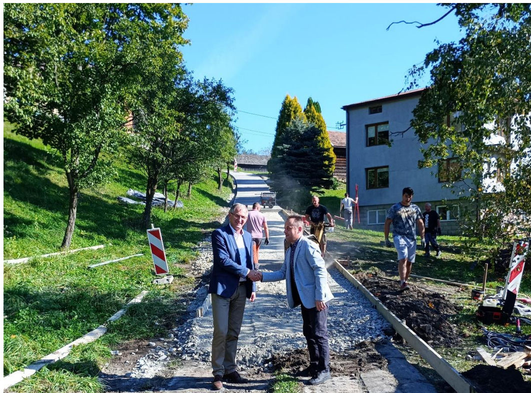
Remont drogi „do Ptaka” w Połomii Wyżnej.
