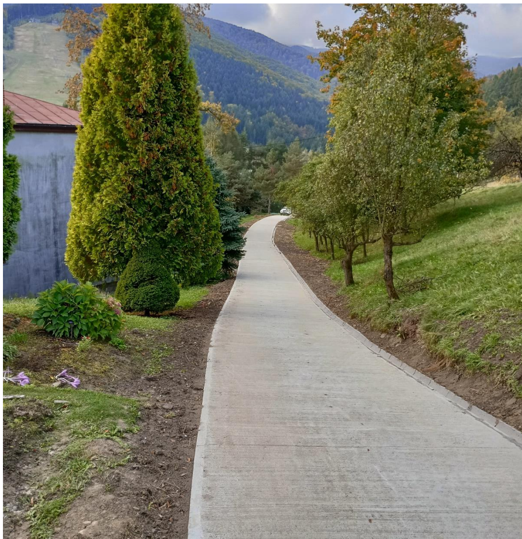
Efekt końcowy remontu drogi i montażu nowego skutecznego odwodnienia liniowego.
